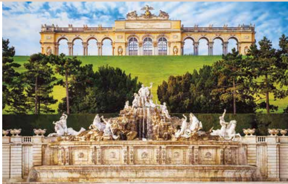
Pre kaskády Neptúnovej fontány v Schönbrunne navrhol Kempelen dômyselný systém čerpadiel, ktoré poháňala jeho parná turbína, foto wikipédia/Simon Matzinger.
