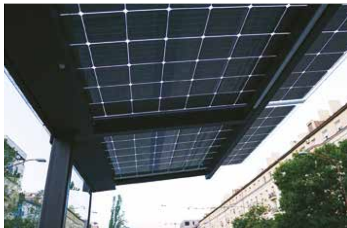
Detail strechy prístrešku na bratislavskej zastávke Račianske mýto s fotovoltickými panelmi, foto L. Kralovičová
