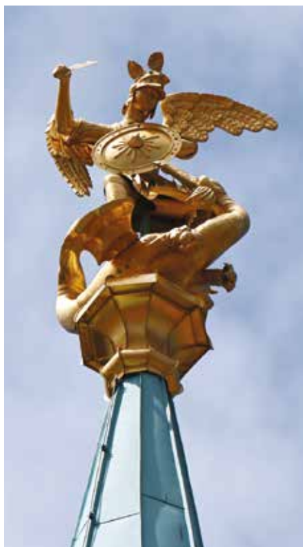
Reštaurovaná plastika sv. Michala archanjela bojujúceho s drakom na hrote Michalskej veže. Jej obnova bola ukončená v roku 2023. Zahŕňovala najmä nahradenie jej chýbajúcich častí, zacelenie dier po projektiloch strelných zbraní, odstránenie starej koróznej vrstvy a chemickú pasiváciu povrchu a nakoniec pokrytie plátkami 23,5-karátového zlata.
